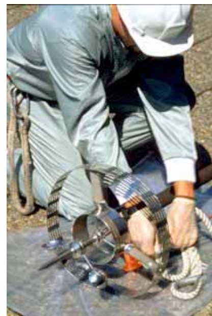
Retirada Cabezal Pararrayos Radiactivo
