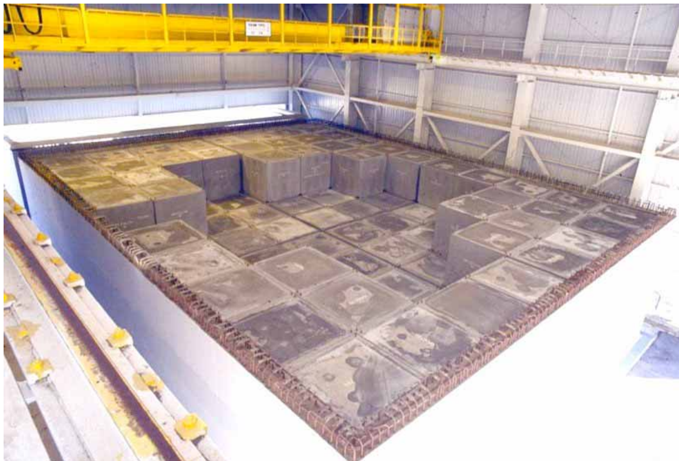
INTERIOR CELDA DE ALMACENAMIENTO
